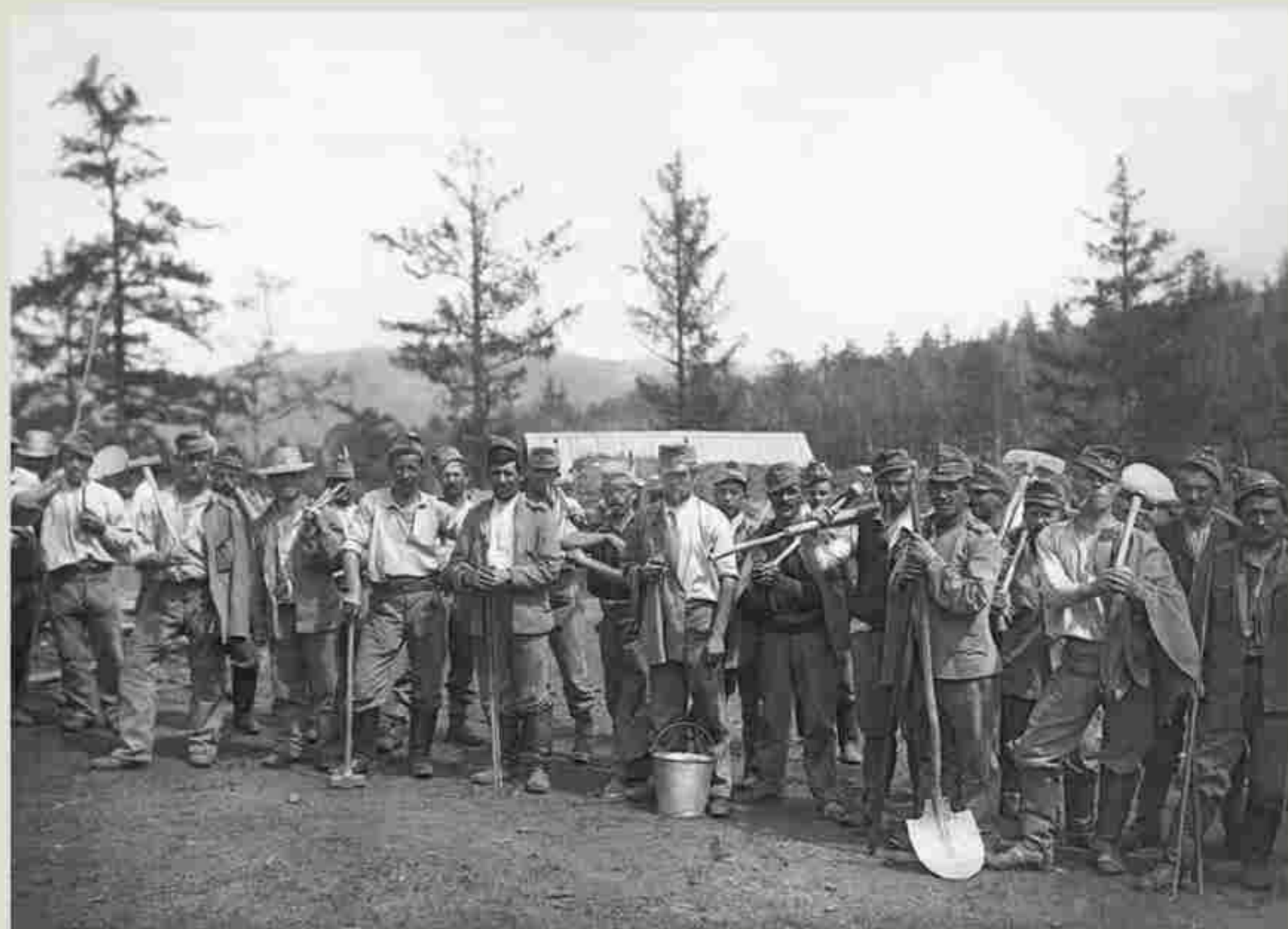
199. Военнопленные на строительстве Ачинско-Минусинской железной дороги. 1914–1916 гг. Н. В. Федоров. МКМ Нст Од-870. Негатив на стекле. 13×18 см
