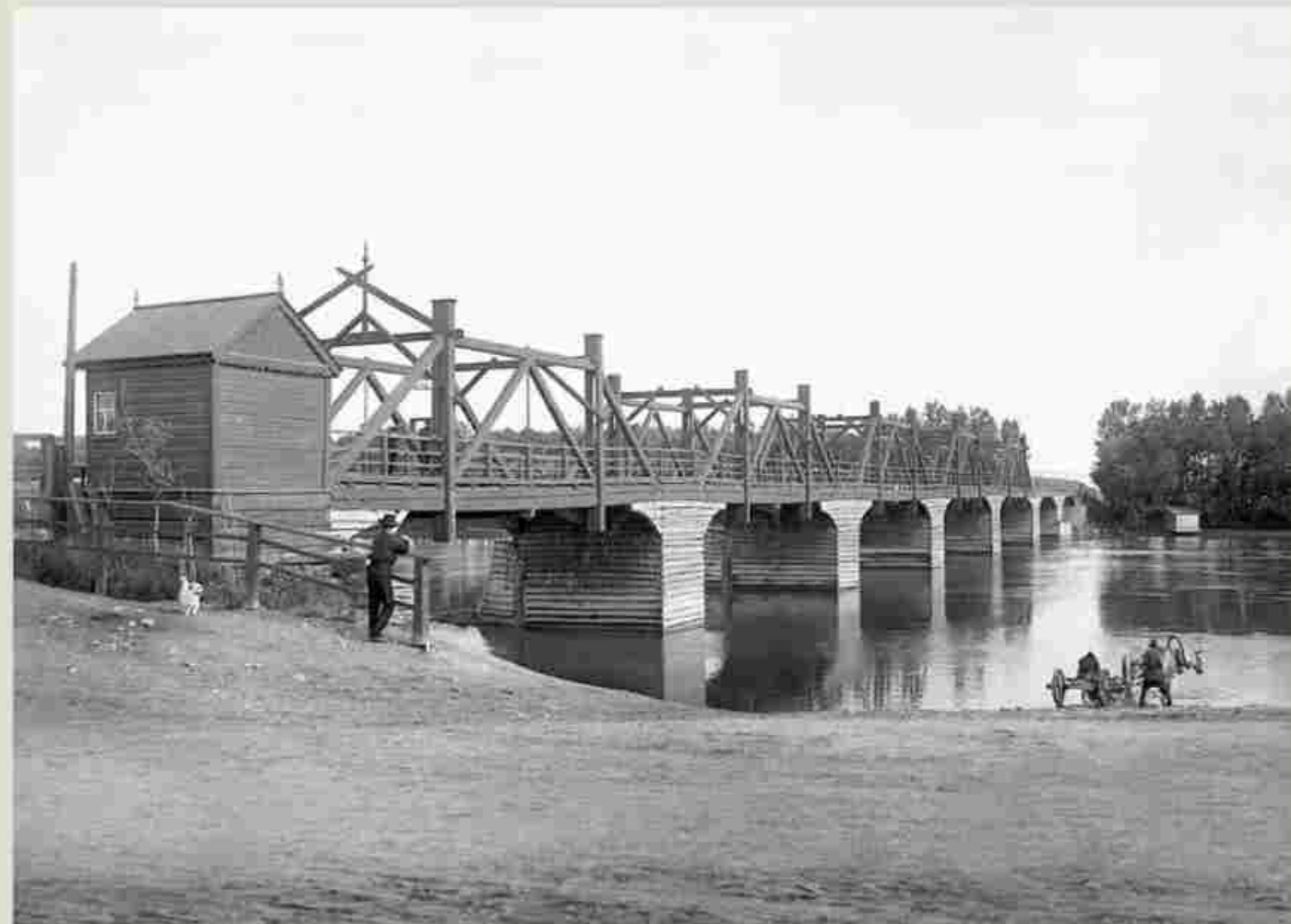
183. Деревянный мост через протоку. Минусинск. 4 августа 1911 г. Н. В. Федоров. МКМ Нст ОФ-Бобу. Негатив на стекле. 13х18 см
