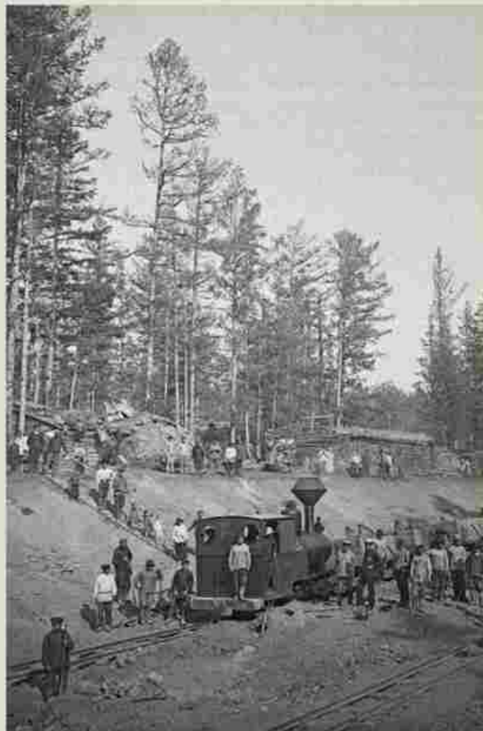
160. Строительство Ачинско-Минусинской железной дороги. 1914–1916 гг. Н. В. Федоров. МКМ. Нст. Оп-847. Негатив на стекле. 8,5×12 см
