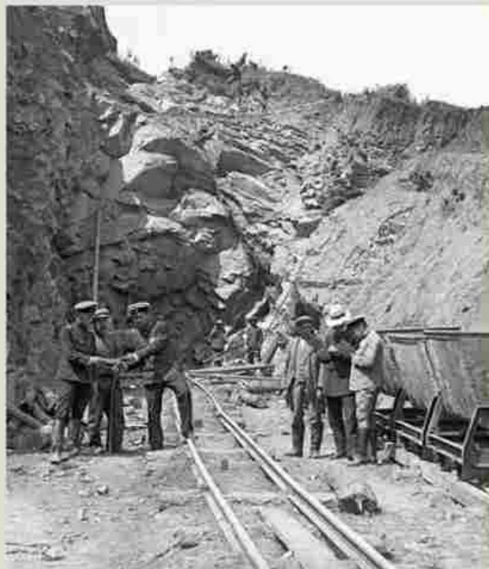
196. Строительство Ачинско-Минусинской железной дороги, 1914–1916 гг. (фрагмент). Н. В. Федоров. МКМ Нст ОФ-846. Негатив на стекле. 13×18 см
