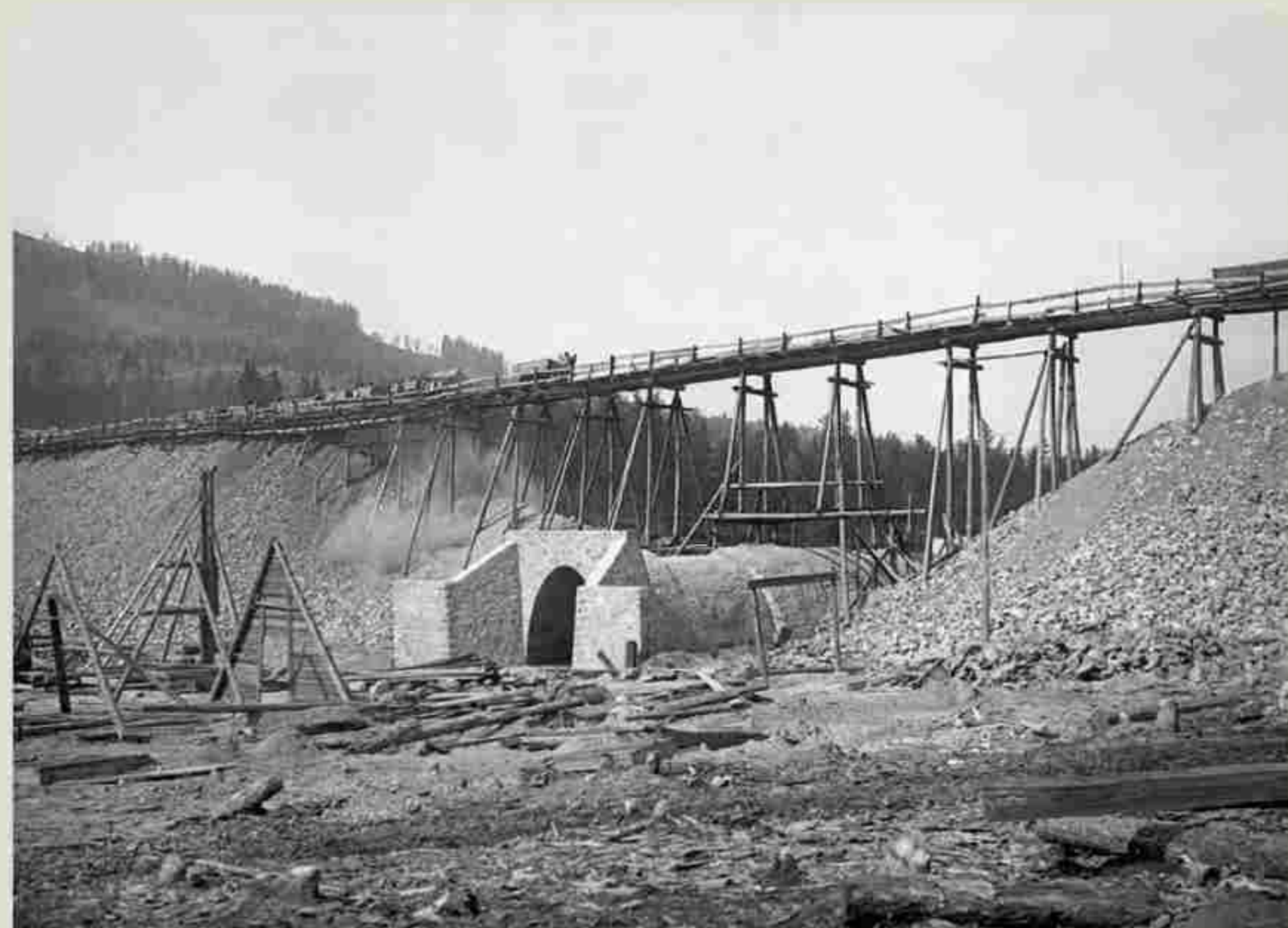
201. Временный деревянный мост над водопропускной трубой на строительстве железной дороги Ачинск — Минусинск. 1914–1916 гг. Н. В. Федоров. МКМ Нст. Об. 861. Негатив на стекле. 13×18 см
