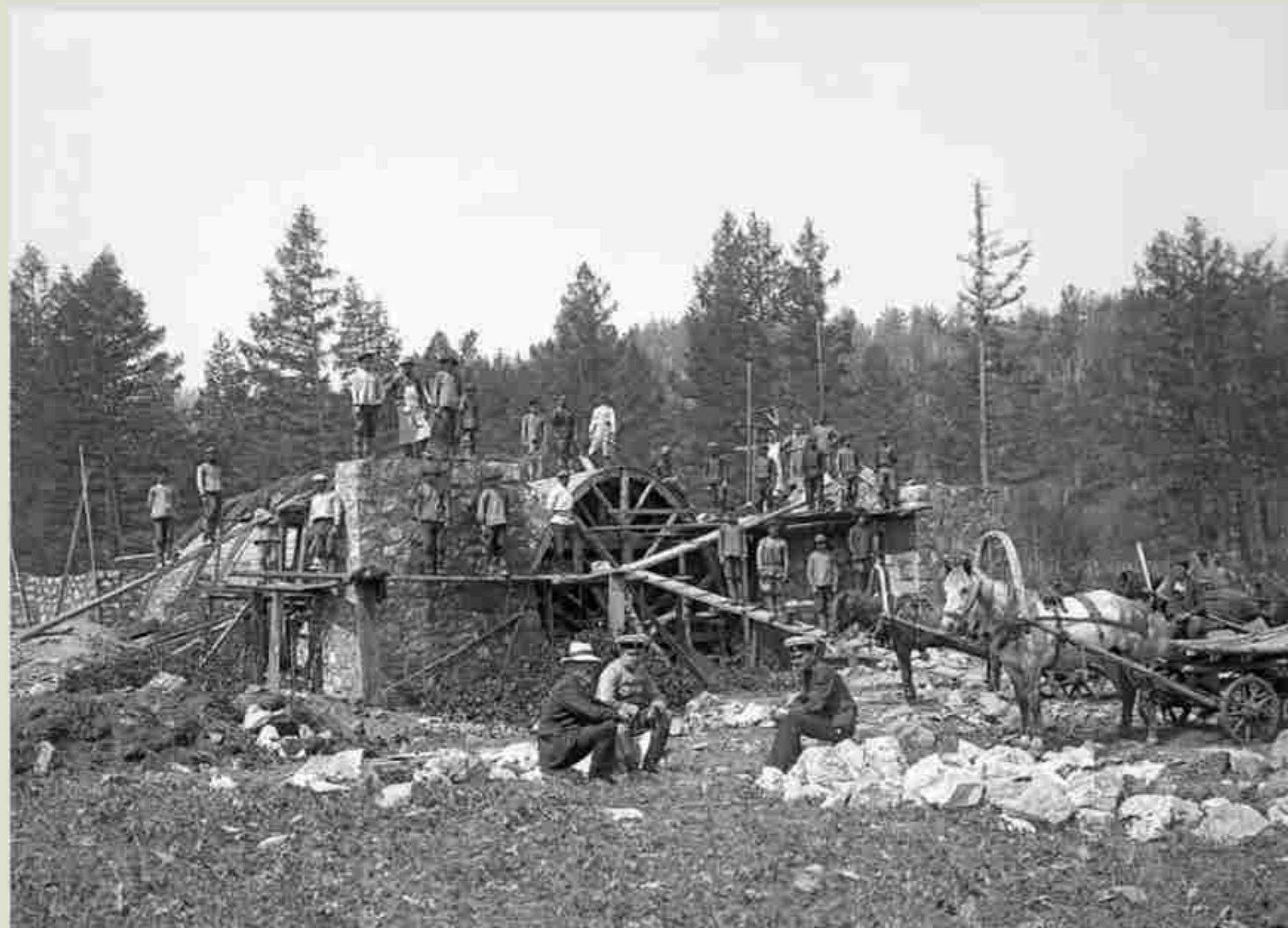
200. Строительство водопропускной трубы на Ачинско-Минусинской железной дороге. 1914–1916 гг. Н. В. Федоров. МКМ Нст. Об. 849. Негатив на стекле. 13×18 см
